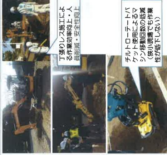
丁張りレス施工による作業効率向上・人員削減・安全性向上
