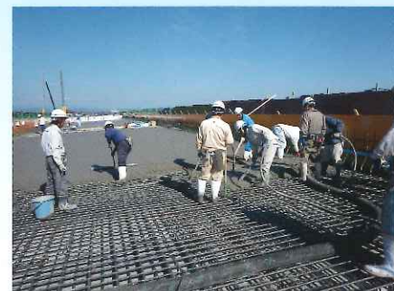
床版コンクリート打設状況
