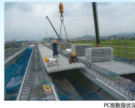
PC板敷設状況
