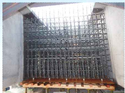
連結横げた 鉄筋組立て完了
