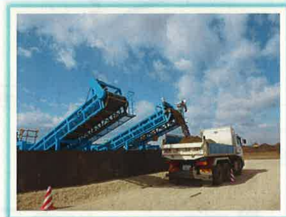
(混合処理土 搬出状況)
